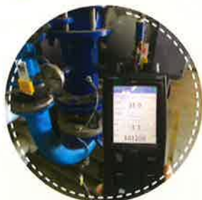
設備機房溫度檢測
