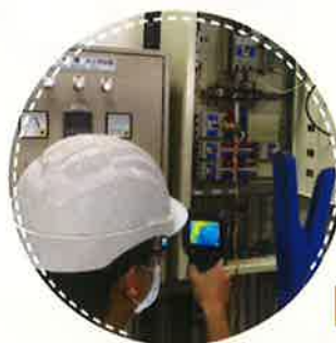
電力盤熱點量測
