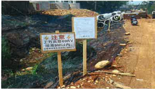
圖 5-4 工地豎立警示牌
