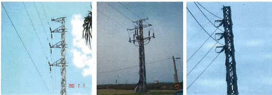
圖 2-6 鐵柱型支持物外觀(大部份用於 69 千伏)
